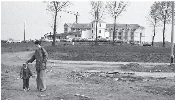
Budowę nowego kościoła interesowali się mieszkańcy Osiedla Północ. Wielu z nich na zasadzie wolontariatu pomagało dobrowolnie przy pracach budowlanych
