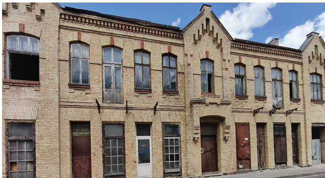
Kamienica przy ul. L. Waryńskiego 1 przez wiele lat straszyla w centrum miasta. Przed tegorocznym Suwałki Blues Festiwalem jej nowy właściciel oczyścił zewnętrzną elewację budynku
