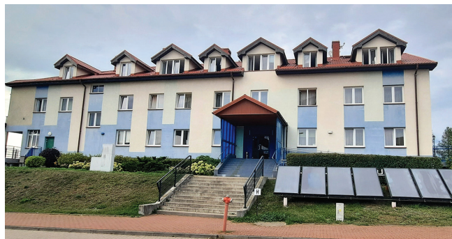
Budynek na stadionie piłkarskim przy ul. Zarzecze 26
