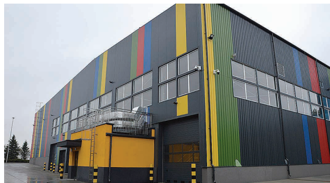
Elewacja sortowni utrzymana jest w kolorystyce pozostałych budynków PGO
