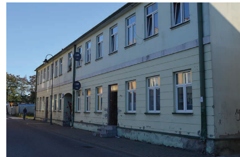
ZBM w budynku Wesola 30 przeznaczył dwa lokale na program „Mieszkanie za remont”
