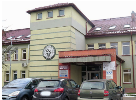
Przed laty w obecnym budynku Ośrodka Rehabilitacji przy ul. L. Waryńskiego był żłobek wybudowany za pieniądze z NFOZ
