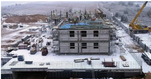
Przy ul. Franciszkańskiej suwalski Zarząd Budynków Mieszkalnych TBS w ubiegłym roku rozpoczął budowę czwartego bloku z mieszkaniami pod wynajem
