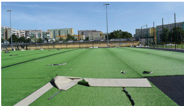
W Szkole Podstawowej nr 7 im. św. Jana Pawła II przygotowana jest już nawierzchnia utwardzona i rozkładane są rolki ze sztuczną nawierzchnią
