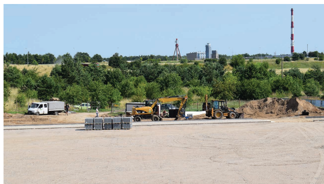
W Szkole Podstawowej nr 5 im. Alfreda Wierusza-Kowalskiego nadal trwają prace przygotowawcze do utwardzenia boiska
