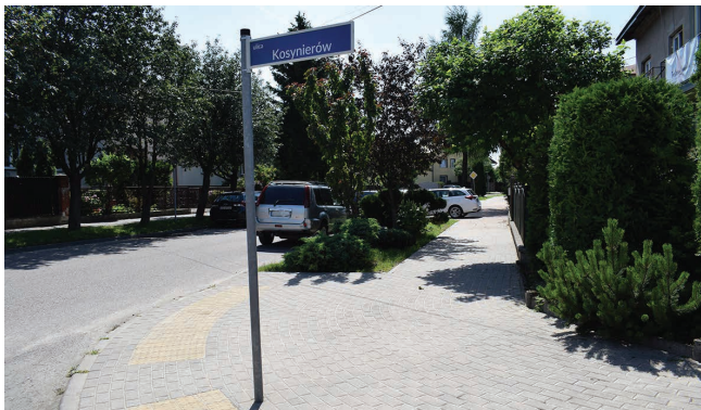
Niedawno wyremontowano 250 m chodnika przy ul. Kawaleryjskiej
