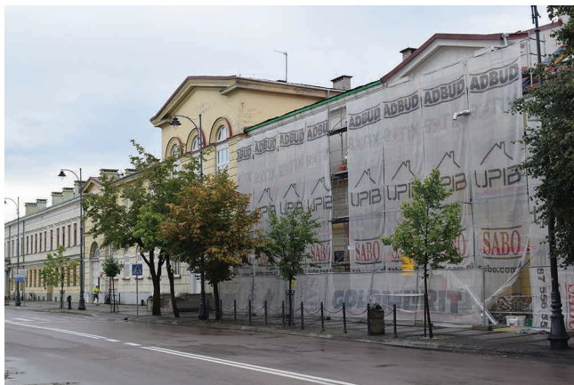
Trwa remont elewacji zabytkowego budynku I LO im. Marii Konopnickiej
