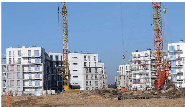
Najnowsze osiedle domów wielorodzinnych szybko powstaje na tzw. Sobolej Bieli
