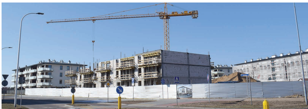
Od kilku lat trwa budowa osiedla budynków wielorodzinnych przy ul. Bydgoskiej
