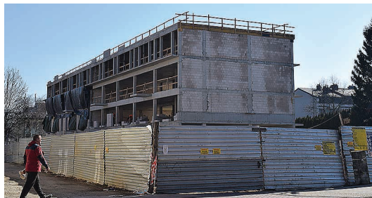
Budowa nowego bloku przy ul. E. Plater (za katedrą św. Aleksandra)
