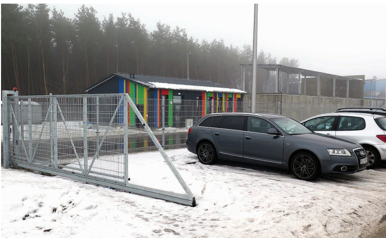
W ramach projektu wykonano nowe ogrodzenie terenu PSZOK wraz z bramą wjazdową i parkingami
