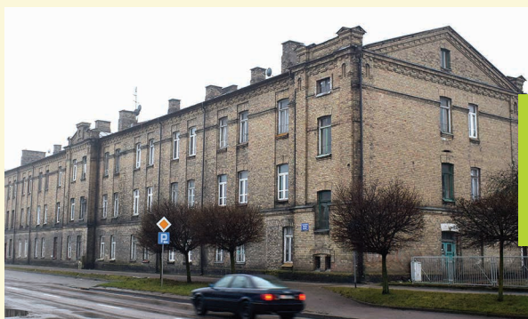
Modernizacja budynku mieszkalnego przy ul. Sejneńskiej 22 5 125 000 zł
