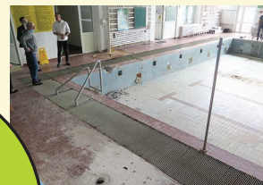
Remont pływalni przy SP nr 10
