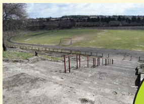
Przebudowa stadionu przy SP nr 5
