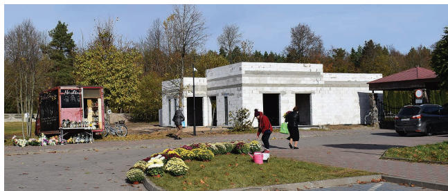
Budowa budynku administracyjno-usługowego potrwa do drugiej połowy przyszłego roku
