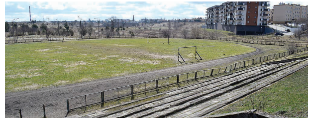
Boisko przy SP nr 5 wymaga generalnej przebudowy
