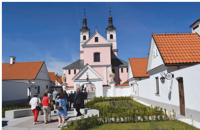
Odremontowane eremy górnego tarasu
