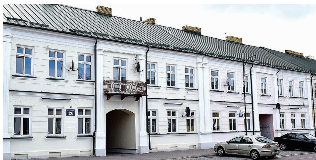
Kamienice przy ul. T. Kościuszki 18, 20 i 26 przeszły kompleksową termomodernizację
