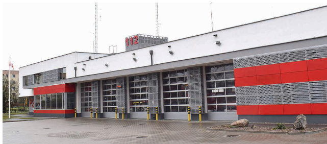
W oddanej do użytku w październiku 2019 r. siedzibie JRG Nr 2 przy ul. W. Witosa, znajduje się część biurowa, a pod nią część szkoleniowa oraz ratowniczo-gaśnicza z pięcioma boksami dla samochodów gaśniczych i myjnią
