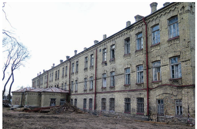
Na wniosek Caritasu Diecezji Elckiej na remont i konserwację fasady budynku w zespole pokoszarowym i kaplicy (1898 r.) Ministerstwo Kultury, Dziedzictwa Narodowego i Sportu w tym roku przeznaczy 270 tys. zł
