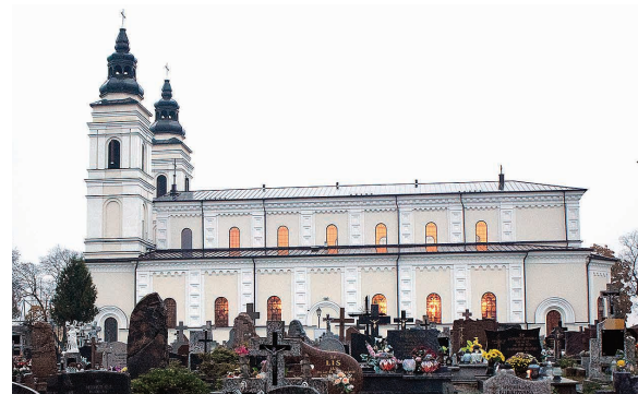
W kościele parafialnym pw. św. Apostołów Piotra i Pawła odnowiono elewację
