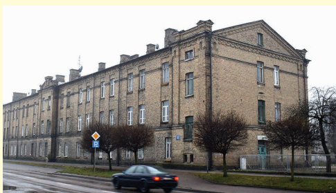
Modernizacja budynku przy ul. Sejneńskiej 22 wraz z zagospodarowaniem terenu – 2 000 000 zł
