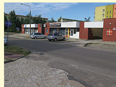
Przebudowa ul. L. M. Paca – 928 517 zł
