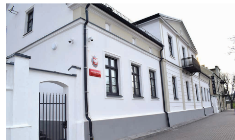
Nowy budynek Żłobka Miejskiego znajduje się przy ul. T. Kościuszki 6
