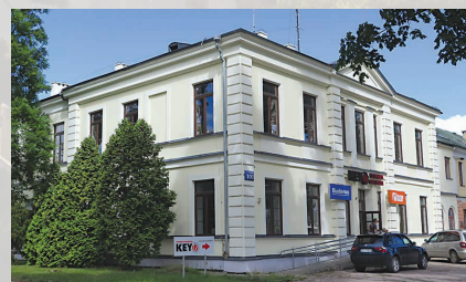
Budynek byłego suwalskiego szpitala powiatowego przy ul. T. Kościuszki
