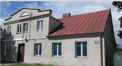
Ulica Hamerszmita 13 – najstarszy budynek w Suwałkach zbudowany zapewne w drugiej połowie XVIII wieku
