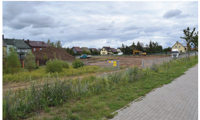
Rozpoczęły się prace ziemne przy budowie zbiornika retencyjno-rozsączającego przy suwalskiej ul. Krakowskiej
