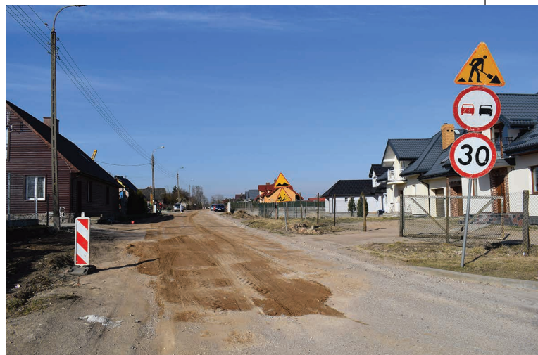
Utrudnienia w ruchu występują na ulicy Krzywólka, która jest przebudowywana od pętli autobusowej do mostu na Czarnej Hańczy. (Więcej na ten temat w relacji z sesji Rady Miejskiej na str. 7)
