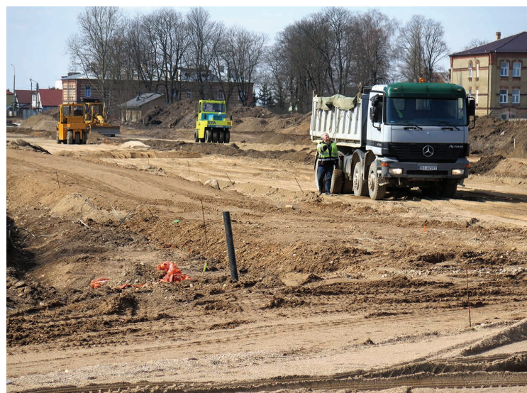
W związku z przebudową ul. Leśniej z przebiegiem do ul. Utrata wraz z przebudową skrzyżowań mogą wystąpić utrudnienia w ruchu drogowym i pieszym
