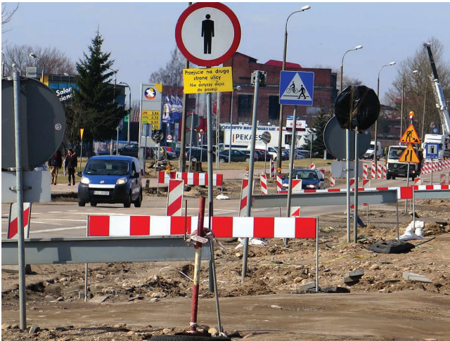
Trwa przebudowa ulicy Sejneńskiej od ul. Młynowej do granic administracyjnych miasta. Utrudnienia zgodnie z planem mają potrwać do 30 września
