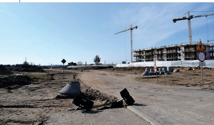
Zgodnie z planem do sierpnia 2018 r. jest wyłączony ruch drogowy na ul. Rotmistrza Witolda Pileckiego. Widząc tempo pracy drogowców trudno będzie dostrzymać im ustalonego terminu oddania do użytku tej drogi
