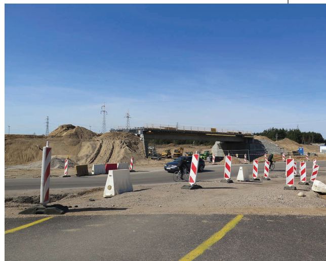
Wciąż jest utrudniony przejazd ulicą Reja ze względu na długą wyczekiwaną budowę obwodnicy Suwałk
