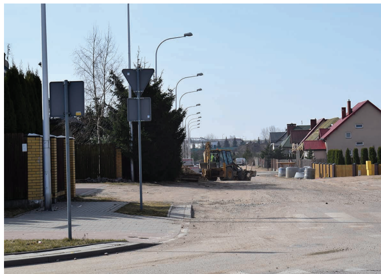
Kierowcy mogą napotkać utrudnienia w ruchu na ulicach: Wrocławskiej, Legnickiej, Katowickiej i Gorzowskiej w związku z ich przebudową
