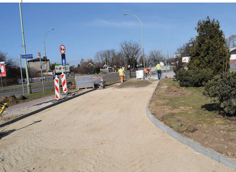
W związku z przebudową chodnika i ścieżki rowerowej przy ulicy Jana Pawła II (w rejonie skrzyżowania z ul. Gen. Z. Podhorskiego) utrudnione poruszanie mają piesi
