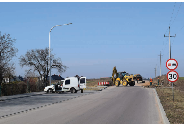
Od 9 kwietnia pojawiły się utrudnienia w ruchu drogowym na ulicy Zastawie – od ulicy Bałtyckiej w kierunku nowobudowanego osiedla domów jednorodzinnych
