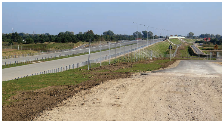
Tak wygląda obwodnica Suwałk pomiędzy ulicami Reja i Pułaskiego
