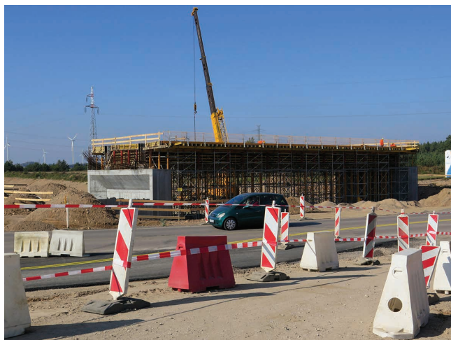
Powstaje już wiadukt nad ulicą Reja, którym dojechać będzie można do cmentarza i Jeleniewa
