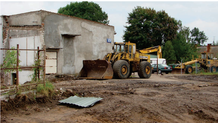
Rozpoczął się pierwszy etap budowy nadrzecznych bulwarów
