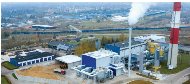
Planowana inwestycja miałaby powstać na terenie przemysłowym przylegającym do działającej elektrociepłowni PEC Suwałki, przy ulicy Przemysłowej
