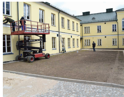
Na dziedzińcu wewnętrznym archiwum trwają jeszcze prace przy północnej elewacji budynku
