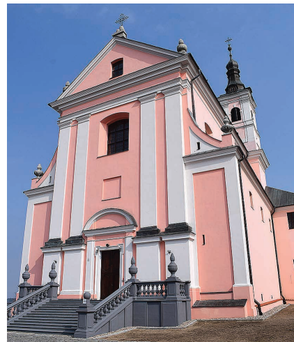
Odnowione główne schody wejściowe do kościoła
