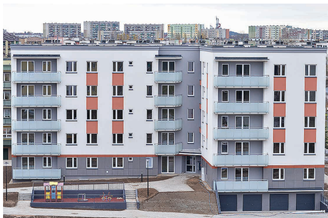
Zrealizowany budynek przy ul. I. Daszyńskiego 27A
