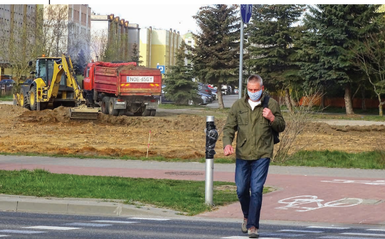
Rozpoczęła się już budowa nowej drogi
