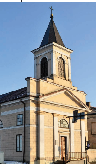
Z budżetu miejskiego dofinansowano remont dachu w kościele ewan-gelickim
