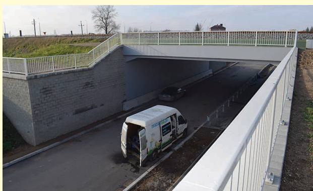
Przebudowa ul. Sejneńskiej wraz z budową odcinka od ul. Sejneńskiej do ul. Utrata z mostem i tunelem – 8 229 822 zł
