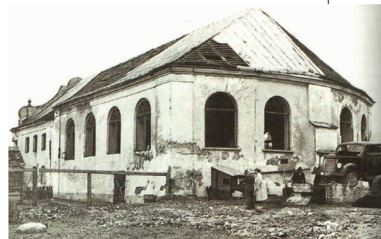
Suwalska synagoga zniszczona przez Niemców – widok z 1955 r. – została rozebrana pod koniec lat 50. W tym miejscu wybudowano Osiedle II
