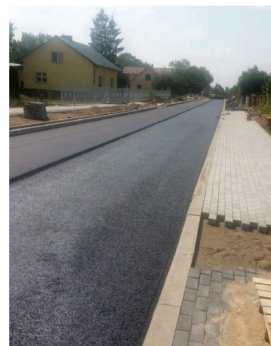
Do 18 października tego roku powstanie nowa droga o długości 0,9 km, wraz z pełną infrastrukturą: jezdnią, ścieżkami dla pieszych i rowerzystów oraz siecią kanalizacyjną, ciepłowniczą i energetyczną. Właśnie rozpoczyna się wylanie asfaltu
