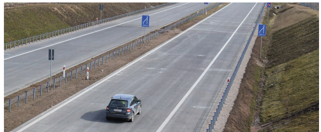
18 marca: obwodnica Suwałk w pobliżu ul. Reja
