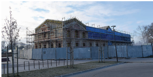
Trwa rozbudowa dawnej łaźni miejskiej przy ulicy Andrzeja Wajdy
