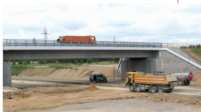
Wiadukt nad obwodnicą przy ul. Reja już jest przejezdny
