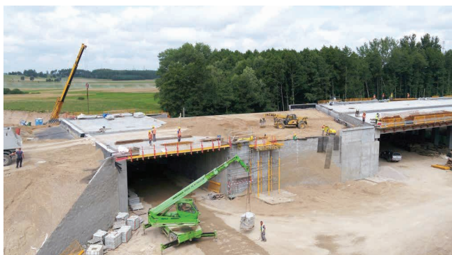
Budowa wiaduktów w okolicy rzeki Czarna Hańcza
