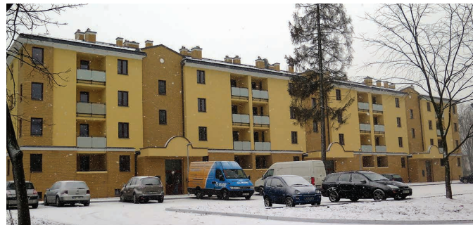
Budynek przy Brzostowskiego 1
