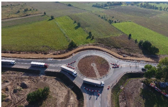
Obwodnica Suwałk w budowie - rondo na ul. Pułaskiego
