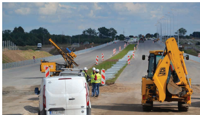
Widok z ulicy Reja na obwodnicę Suwałk wykonaną z betonu
