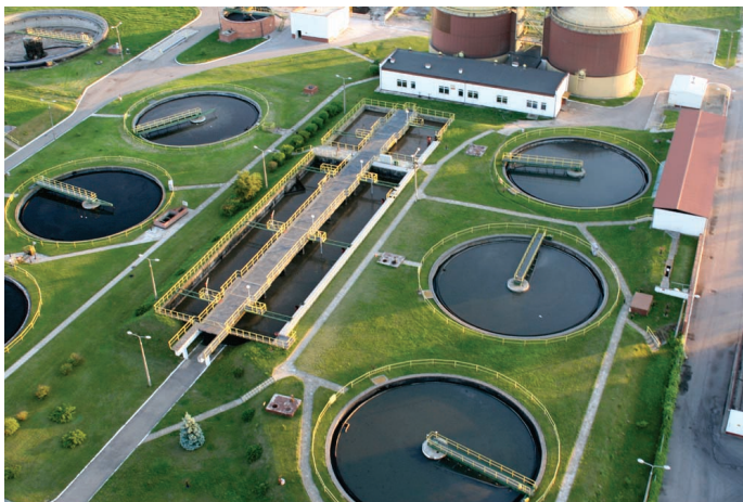
Oczyszczalnia ścieków przed modernizacją
