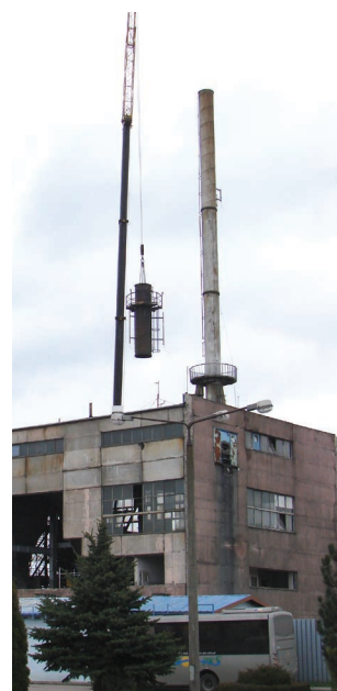
Tak przebiegało zdjęcie górnej sekcji komina
